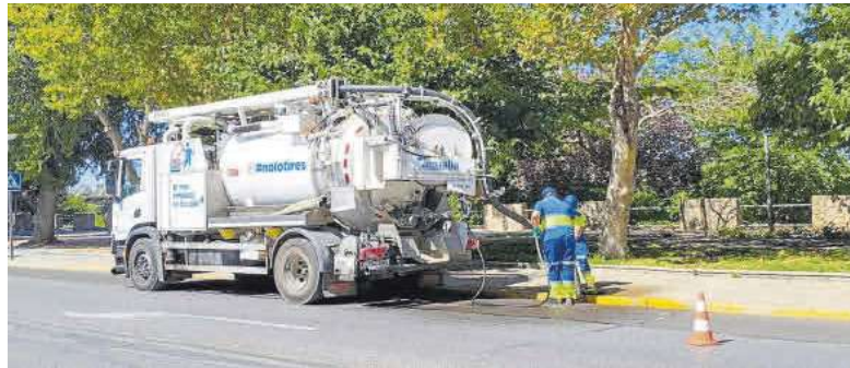
Operarios de Aqualia trabajan en el Paseo Fluvial.
