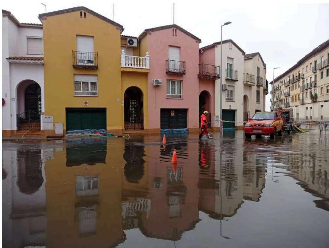
Calle Entretorres de Talavera anegada por el temporal, en febrero 2026 / Carlos Sánchez Jiménez
