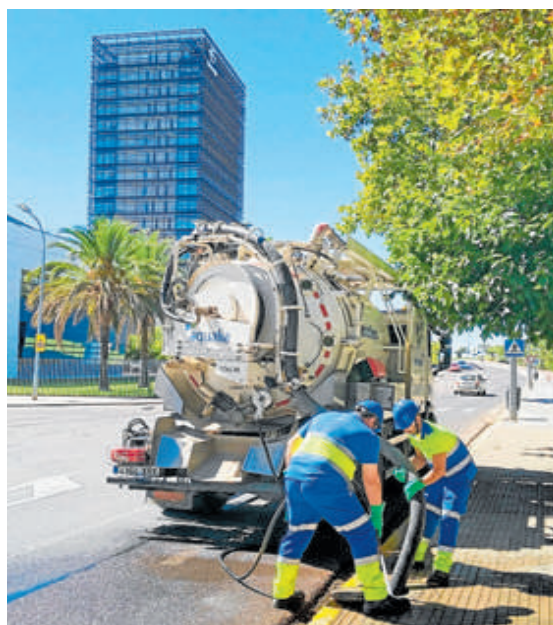
Los operarios limpian una alcantarilla. HOY
